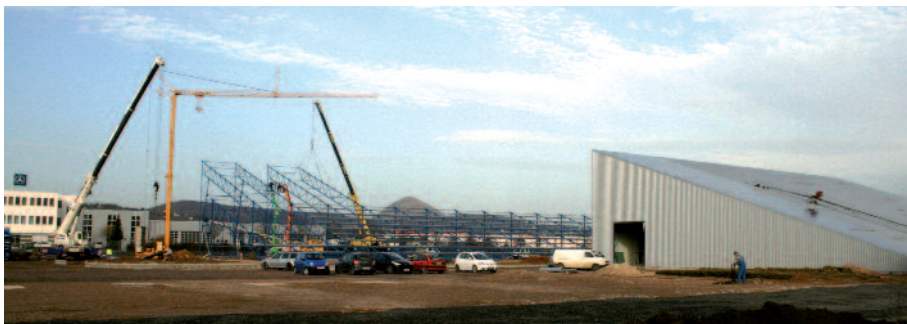
Zwei VEGA-Hallen mit unterschiedlichen Baufortschritt.
