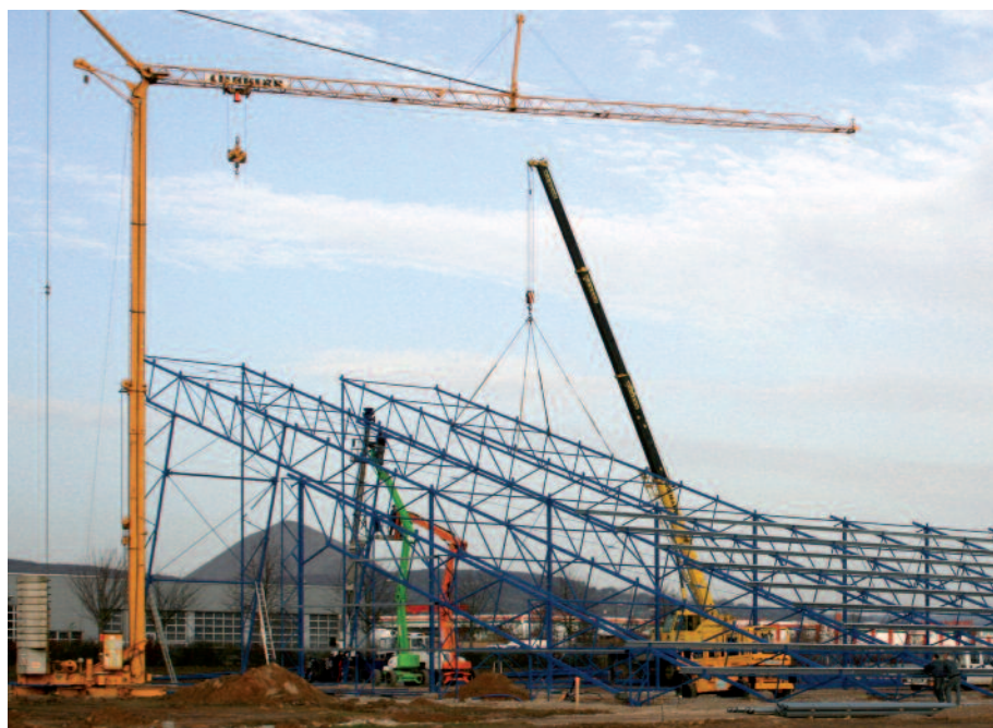
VEGA-Halle in der Bauphase: Aufbau der Stahlträgerkonstruktion.
