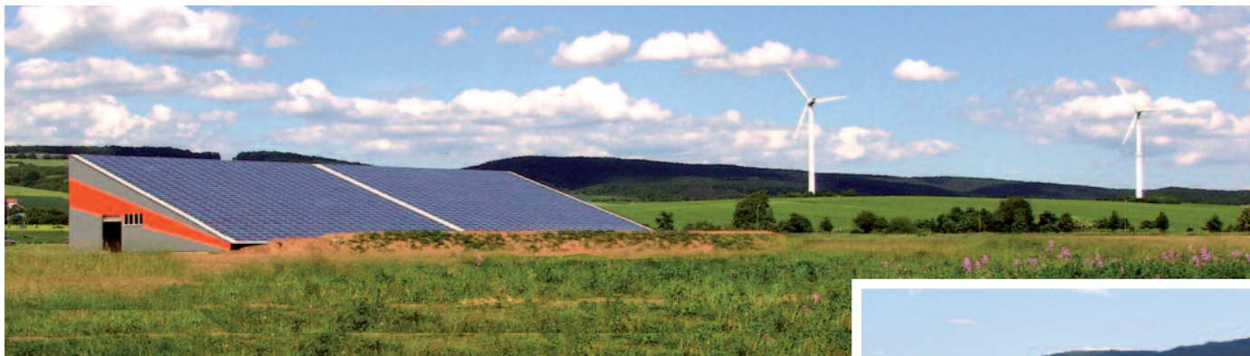
▲ Südansicht der VEGA-Halle: die Photovoltaik-Module bilden eine geschlossene Dachhaut.
