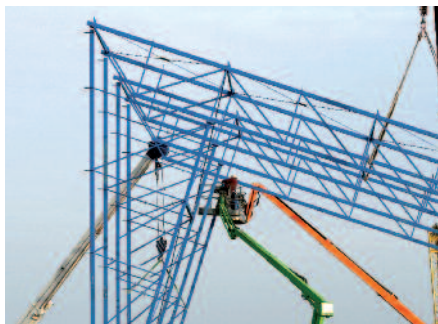
Zusammenbau der Tragwerkskonstruktion.
