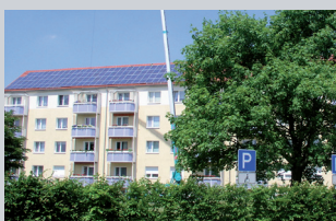
Ort: Halle Leistung: 232,86 kWp
