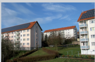
Ort: Nordhausen Leistung: 151,00 kWp
