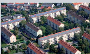
Ort: Köthen Leistung: 251,12 kWp
